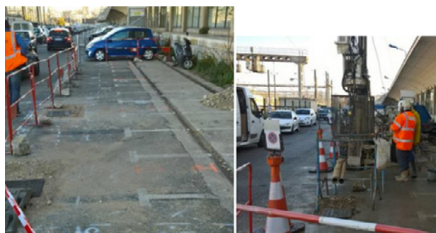
Exemple d'interventions pour les sondages géotechniques
